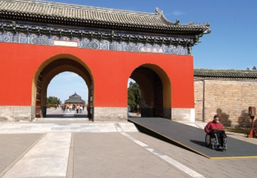
Rampen machen die Anlage zum „Himmelstempel“ für Rollstuhlfahrer recht gut zugänglich
