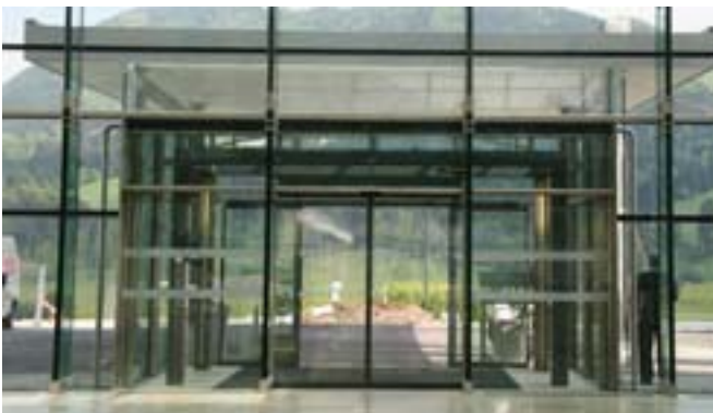
Panorama hinter Glas: Der Eingangsbereich des Rehabilitationszentrums
